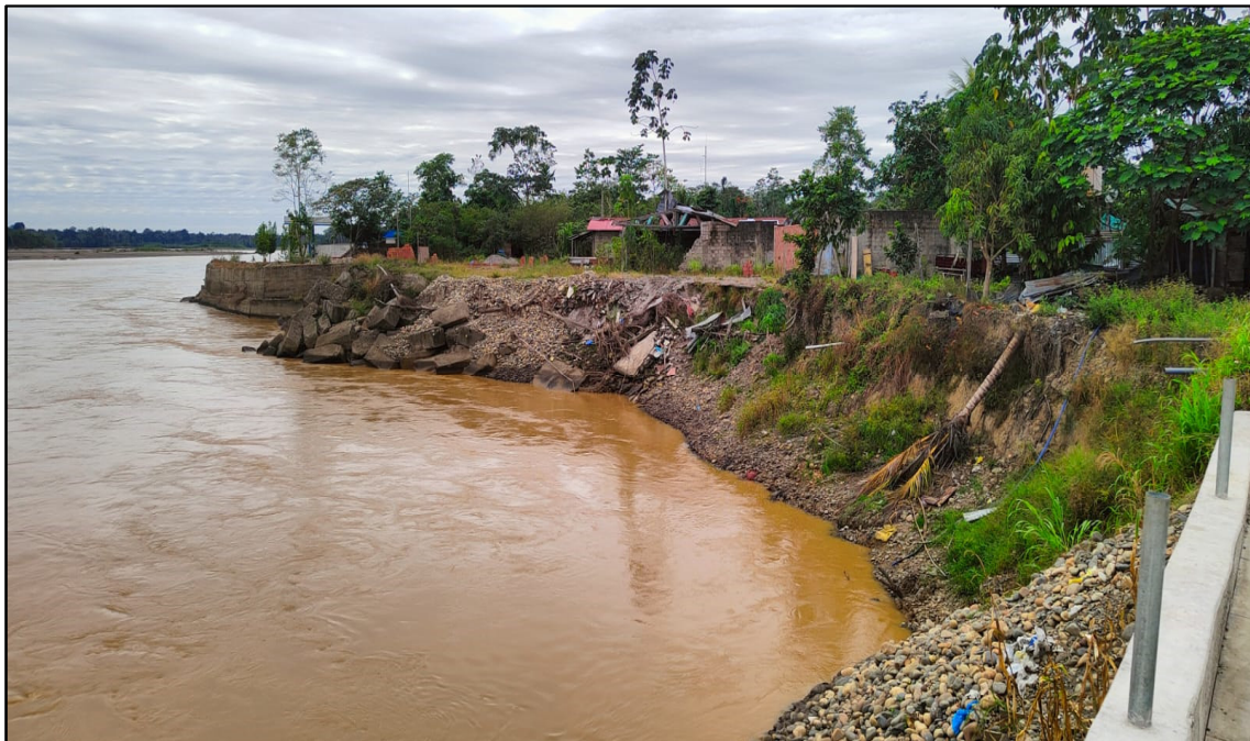
FIGURA N°03: SE PARECIA COLAPSO DE TALUDES A CAUSA DE LA EROSIÓN DEL RÍO
