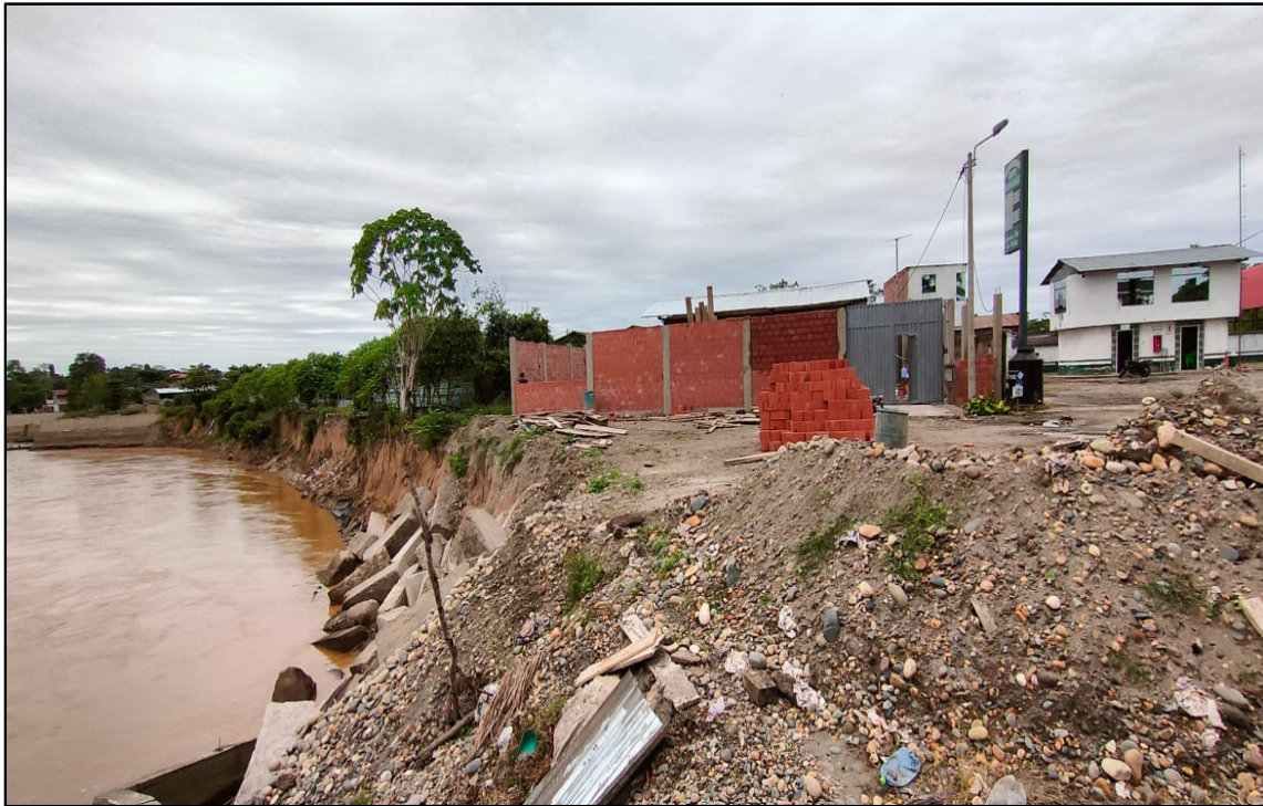
FIGURA N°02: SE APRECIA VIVIENDAS EXPUESTAS AL DESPRENDIMIENTO DE TALUD DE RIBERA DE RIO A CAUSA DE LA SOCAVACIÓN
